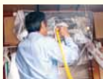
フィン部分は高圧洗浄
