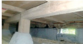
床下の束がズレたり破損していないか点検
