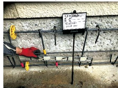
ケミカルアンカーを使用してコンクリート基礎に耐震補強部材を取り付けます。
