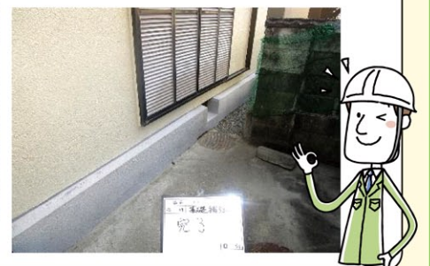
ケミカルアンカーを使用してコンクリート基礎に耐震補強部材を取り付けます。
