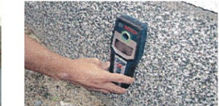
センサーで基礎に鉄筋が入っているかを点検
