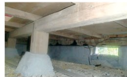
床下の束がズレたり破損していないか点検
