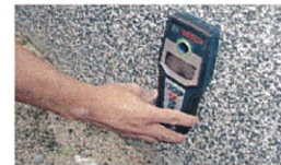
センサーで基礎に鉄筋が入っているかを点検
